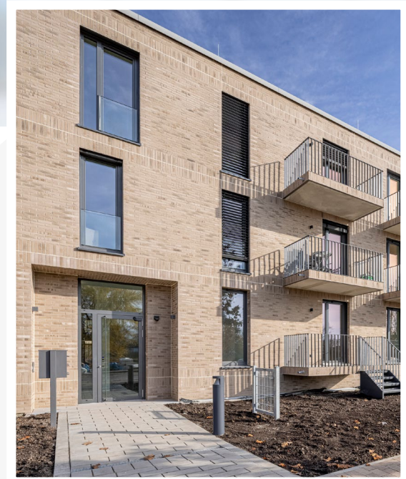
Beispielbild Bellevue 1. Bauabschnitt
