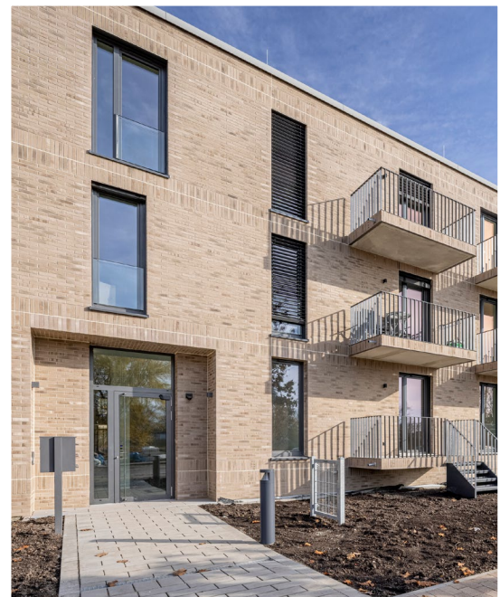
Beispielbild Bellevue 1. Bauabschnitt
