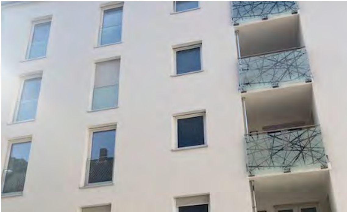
Gebäude von Außen
