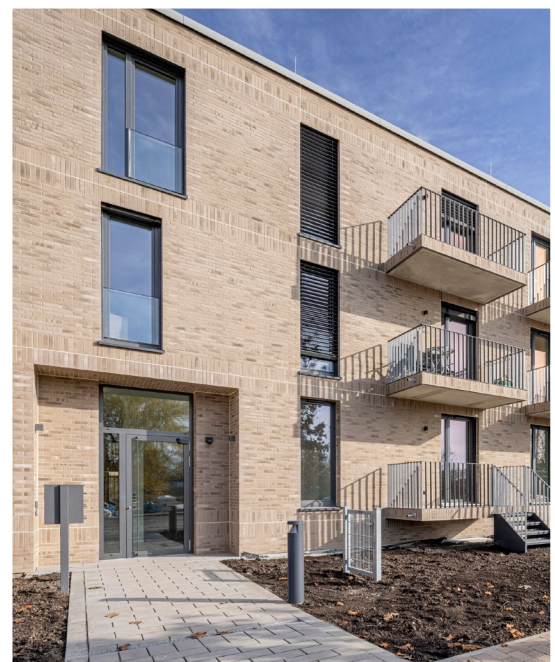
Beispielbild Bellevue 1. Bauabschnitt
